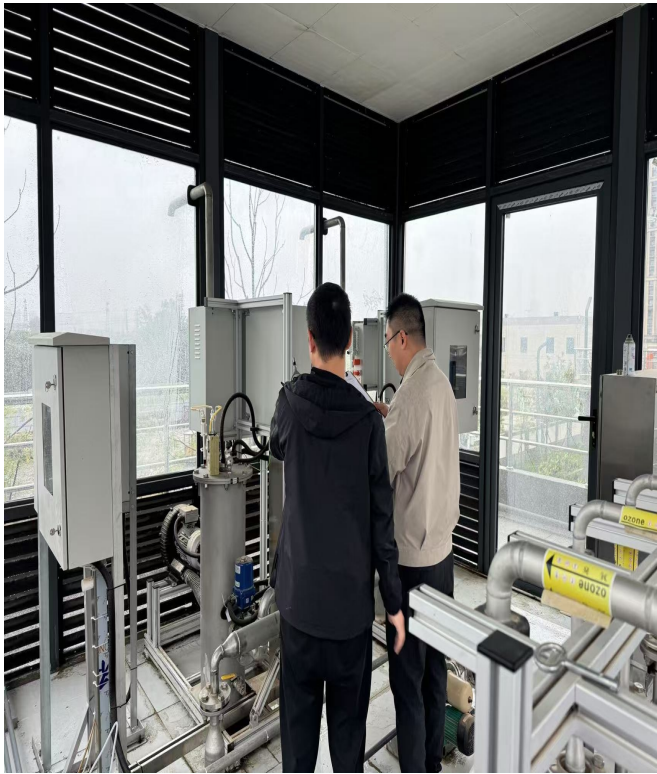
后臭氧投加间采样及测量
