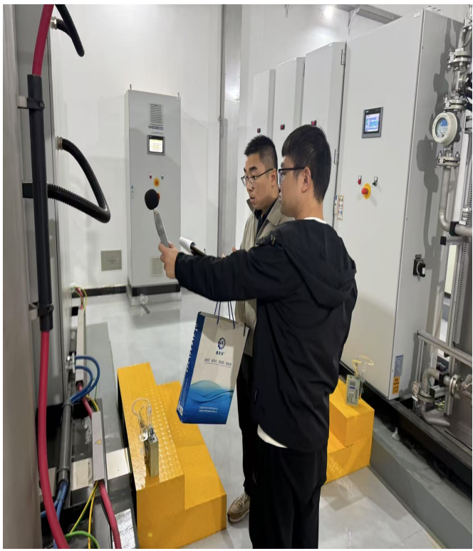
臭氧发生间毒物采样及噪声测量
