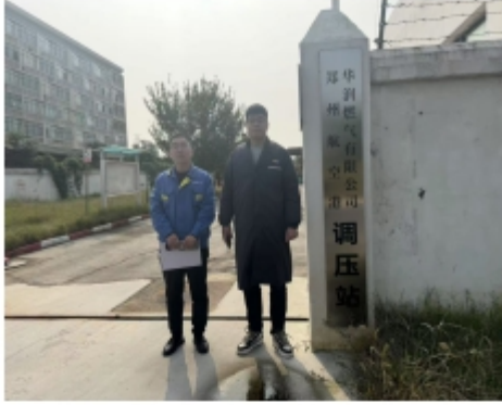
航空港区调压站
