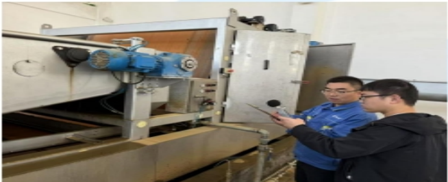
脱水机房噪声测量
