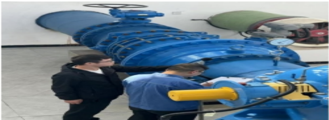
送水泵房噪声测量
