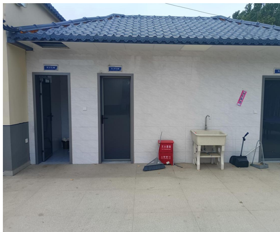
集控站内的卫生间、洗浴间
