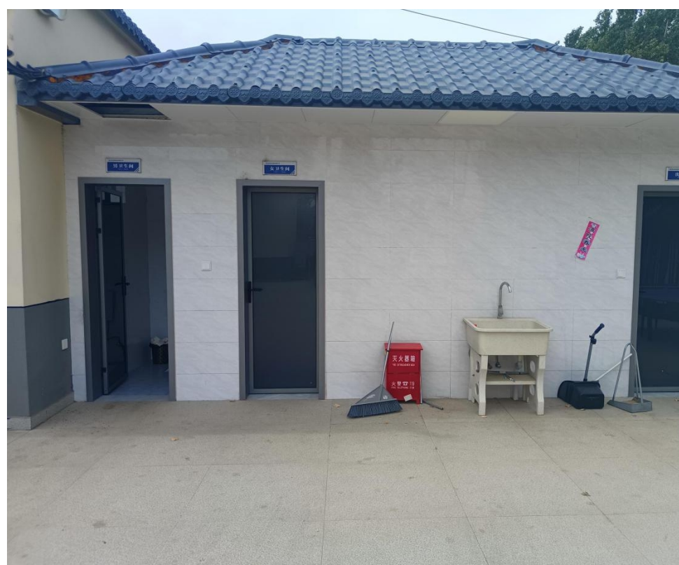
集控站内的卫生间、洗浴间
