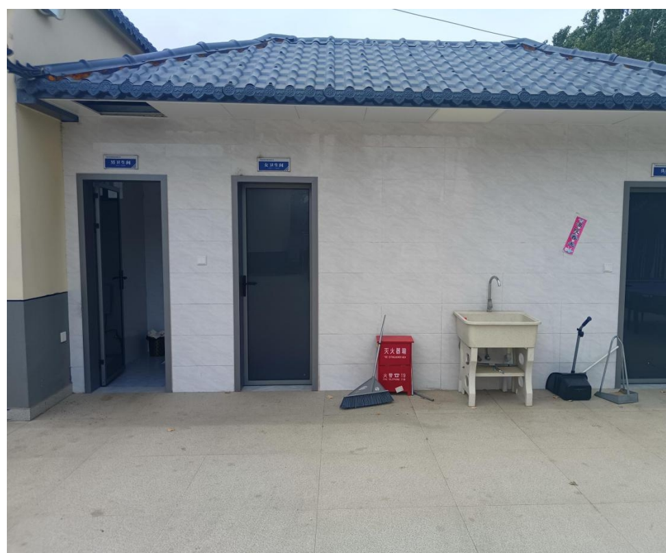
集控站内的卫生间、洗浴间
