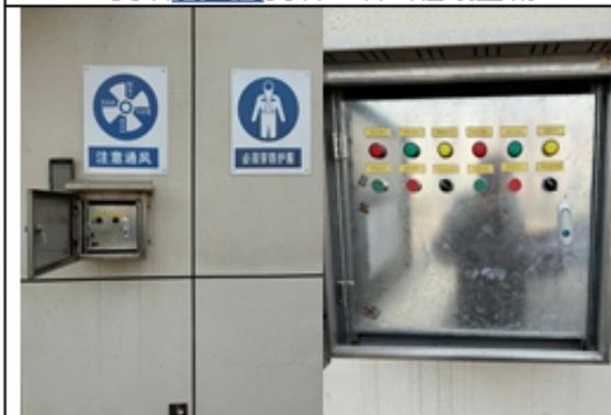
臭氧发生间及次钠储罐间室外风机控制开关
