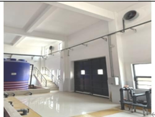
次氯酸钠储罐间排风风机及围堰
