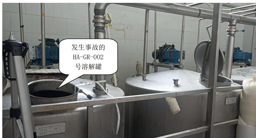
图 3 发生事故的溶解罐
