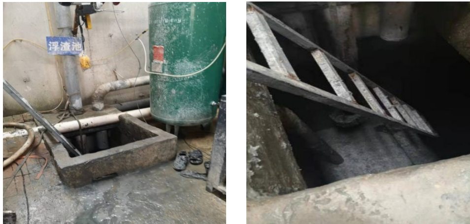
图 16 发生事故的浮渣池
