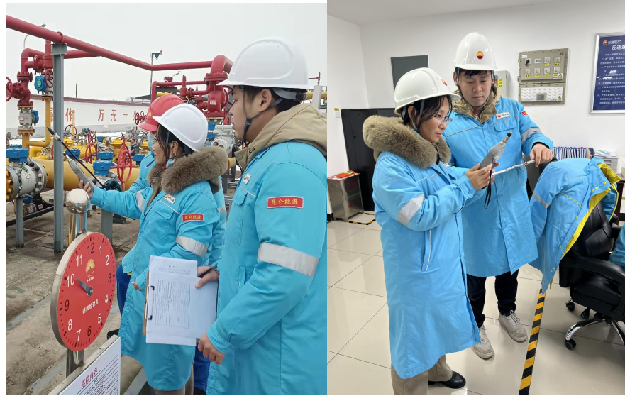
门站工艺装置区和锅炉房噪声测量
