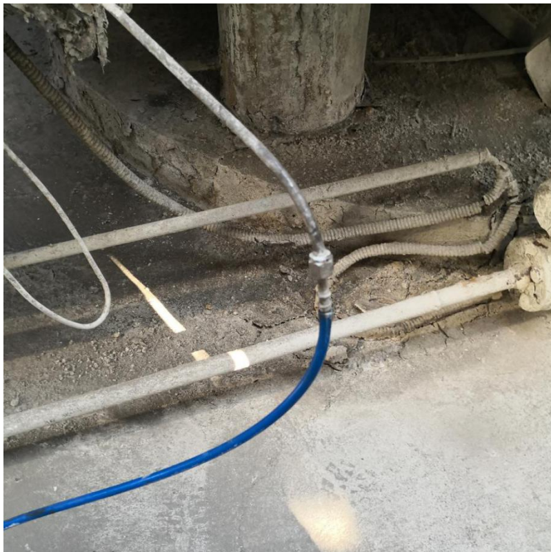
图 4-3 仪表风连接处复原图
